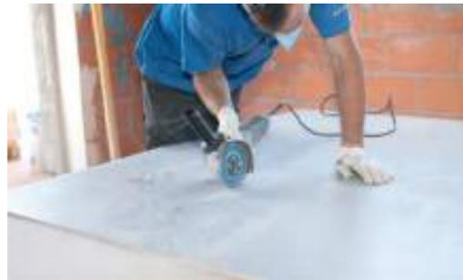
Pour la réalisation d'une coupe de la pièce ARKLAM par disque diamant à sec ou refroidie à l'eau, on recommande l'utilisation à tout moment de guides de support.
