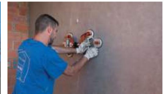
Combiné avec ce système, nous effectuerons l'ajustement de la distance entre les plaques, avec des systèmes manuels de ventouses.
