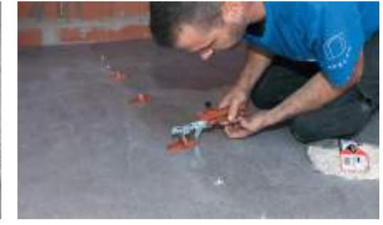
Pour effectuer un bon nivellement entre les plaques, en prenant toujours comme référence les niveaux de la plaque précédente. Nous utiliserons le système de cales dans l'union entre la plaque nouvellement installée et la précédente.
