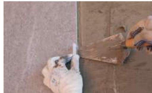
Nous nettoierons les surplus d'adhésif des joints de placement, avant sa prise. À tout moment, il doit être protégé d'un séchage rapide et de présence d'humidité.
