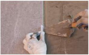
Excess adhesive must be cleaned from the tile-to-tile joints, كل يجمّدها. يجب في كل المادة اللاصقة الفائضة عن مفاصل التركيب قبل تجمّدها. يجب في كل وقت الحرص على تجنب الجفاف السريع ووجود الرطوبة.
