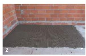
نضع المادة اللاصقة في المنطقة التي تم ضبط قياسات أساسها في الدعامة، ثم Apply adhesive on the back of the ARKLAM sheet using a flat نبسطها بواسطة مالج مسطح. بعد ذلك يتم تمشيطها بواسطة مالج مسنن من فئة 👚 trowel or if necessary by means of a 3 mm notched trowel, in a
