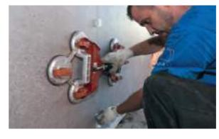
بالموازاة مع هذا النظام، نقوم بتعديل المسافة بين الألواح بواسطة أنظمة يدوية | Combined with this system, the distance between plates will be adjusted by using manual suction cup systems.
