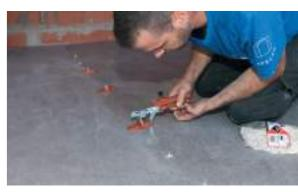
To proceed to the correct levelling between plates, a reference للشروع في ضبط الاستواء بشكل صحيح بين الألواح، بجب الرجوع دائما إلى is always taken from the levels of the previous plate. The مستويات اللوح السابق. سوف نستخدم نظام أسافين في الربط بين القطعة التي تم تركيبها حديثا والقطعة السابقة.
