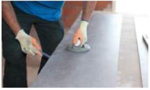
لقطع القطع الصغيرة أو القطع الطويلة المحدودة، يمكننا استخدام القلم الماسي For the cutting of small pieces or reduced lengths, the manual
