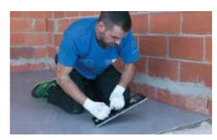
متجانسة وجد مندمجة للمادة اللاصقة. لإجراء هذه العملية، نستخدم المالج of the sheet and to form in this way a uniform and well compacted layer of adhesive. For this operation, a manual or mechanical rubber trowel is used.
