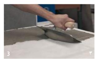
Apply adhesive on the back of the ARKLAM sheet using a flat عند ARKLAM واسطة مالج مسطح أو عند ARKLAM على المادة اللاصقة في ظهر رقاقة horizontal pattern.
