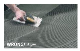
يعتبر اتجاه وتجانس التمشيط مهما جدا، لأن ذلك سوف يضمن الالتحام التام مع . The direction and uniformity of brushing is very important, as this will ensure complete bonding on the back of the piece, avoiding air pockets inside.
