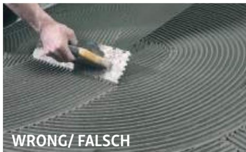
Die Richtung und die Homogenität des Kämmens ist sehr wichtig, weil sie die totale Haftung auf der Rückseite des Teiles garantiert, und die Bildung von Luftblasen verhindert.
