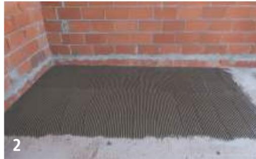
Wir bringen den Kleber auf die abgesteckte Area des Untergrundes, und wir streichen ihn mit der Glättkelle. Danach wird er mit der 8 mm Zahnkelle gekämmt, in horizontale Kämrichtung.
