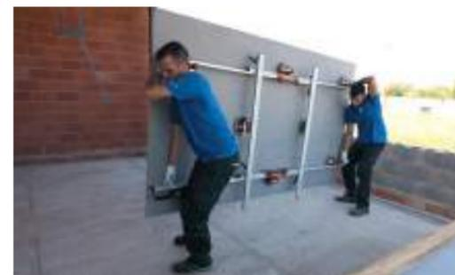
Vor der Anbringung der Sauger auf die ARKLAM Platte, reinigen Sie die Oberfläche und die Haftungsseite der Sauger mit einem feuchten Tuch, um die Haftung zu verbessern.
