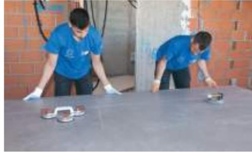
Wenn Sie mit dem Kratzen fertig sind, werden die Teile auf beide Seiten des Schnittes mit der Zange getrennt, indem man in der richtigen Stellung genug Druck ausübt bis sie brechen. Beachten Sie, dass eine oder zwei Personen das Teil halten sollen, damit es nicht runterfällt.
