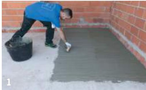
Wir bringen den Kleber auf den abgesteckte Bereich des Untergrundes, und streichen ihn mit der Glättkelle. Danach wird er mit der 8 mm Zahnkelle gekämmt, in horizontale Kämrichtung.
