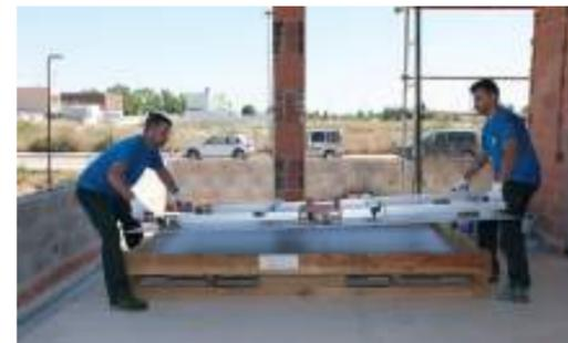
Für den Transport und manuelle Handhabung der ARKLAM Platten werden starre Rahmen benutzt, und immer wenn es möglich ist wird einem Gestell mit Laufrädern für Bewegungen auf gleiche Höhe empfohlen. Mit starkem Vakuumsauger. In diesem Manual wird immer von der Handhabung ganze ARKLAM Teile gesprochen. Deswegen sollen mindestens 2 Werker mit Schutzhandschuhe und Durchrutschschutz für Glashandwerkerarbeit und Sicherheitsschuhe tragen. Beim Arbeiten sollen sie immer gerade stehen.
