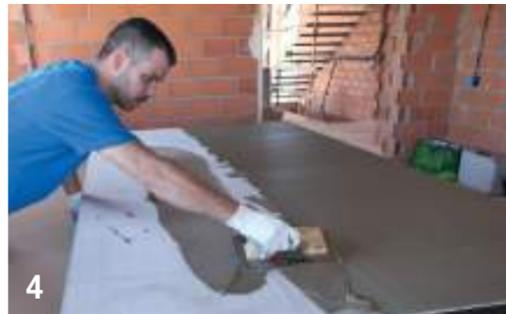
Der Kleber wird auf der Rückseite der ARKLAM Platte mit der Glättkelle angebracht, oder, ggf. mit der 3 mm Zahnkelle in horizontale Kämrichtung.
