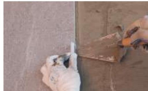
Der Restkleber der Positionierungsfugen wird gereinigt, bevor er aushärtet. Es muss jederzeit von der schnelle Trocknung und den Feuchtigkeit geschützt sein.
