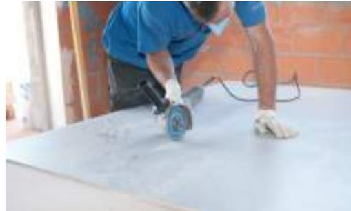
Um das ARKLAM-Teil mit einer trockenem oder mit Kühlung, diamantbesetzten Trennscheibe zu schneiden, empfehlen wir immer die Stützführungen zu benutzen.
