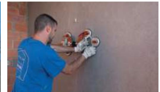
Der Abstand zwischen den Platten wird mit manuelle Saugersystemen in Verbindung mit diesem System reguliert.
