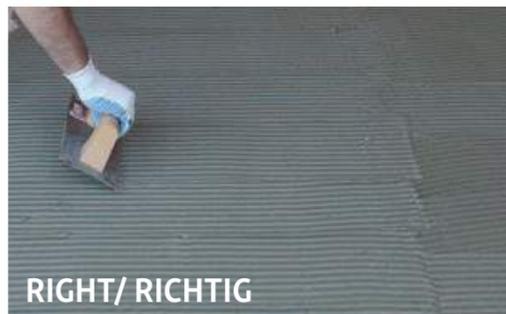
Die Richtung und die Homogenität des Kämmens ist sehr wichtig, weil sie die totale Haftung auf der Rückseite des Teiles garantiert, und verhindert die Bildung von Luftblasen.
