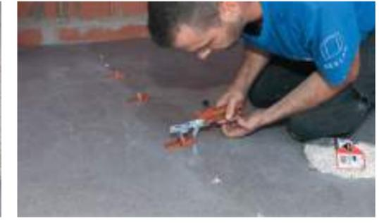
Um die richtige Nivellierung zwischen Platten zu erhalten, werden immer die Stufen der vorherigen Platte als Referenz benutzt. In der Verbindung zwischen der gerade installierten und der vorherigen Platte werden Keile benutzt.
